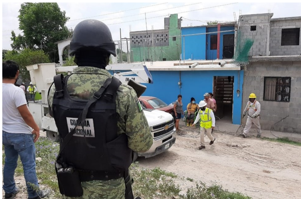
Personal de la CFE y de la Guardia Nacional desmantelando el servicio eléctrico (mayo de 2020)
