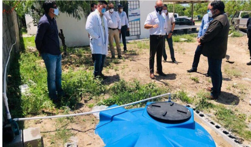
Conexión a la red de agua potable del Centro de salud de Las Higuierillas (agosto 2020)
