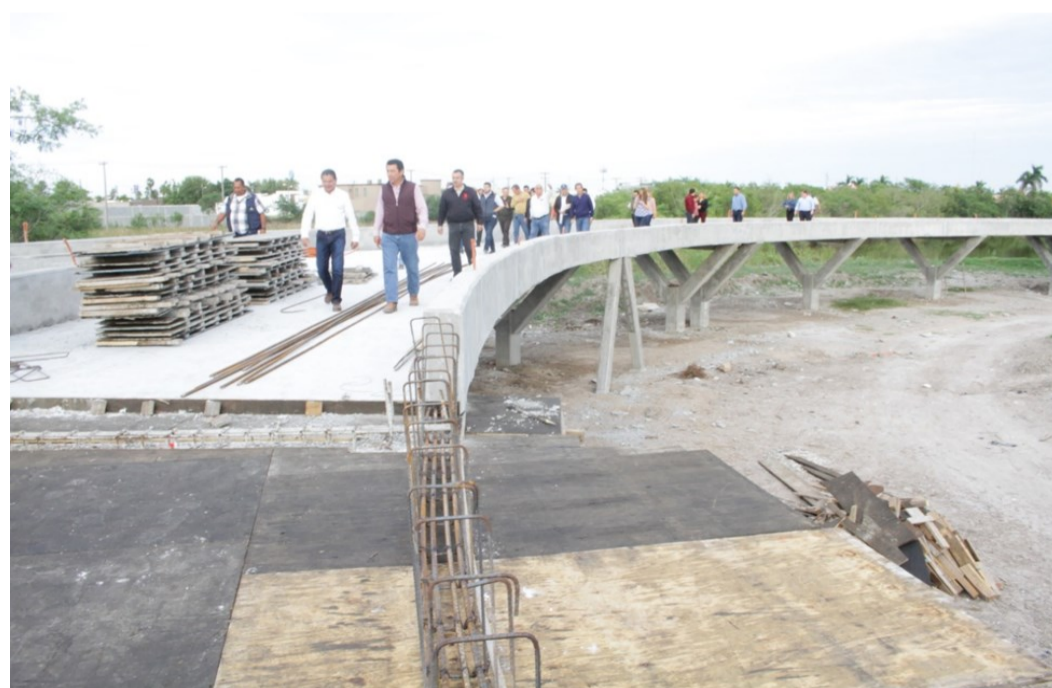
La ciclovía elevada en construcción: visita de obras por parte del gobierno local (noviembre 2018)
